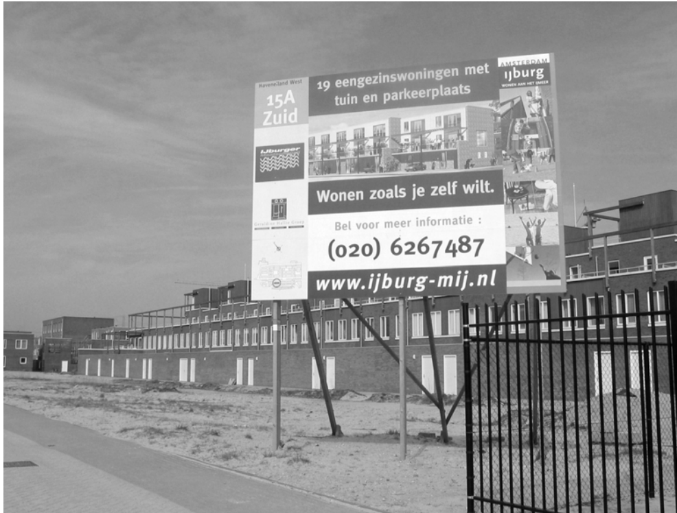
Blok 15a in aanbouw
