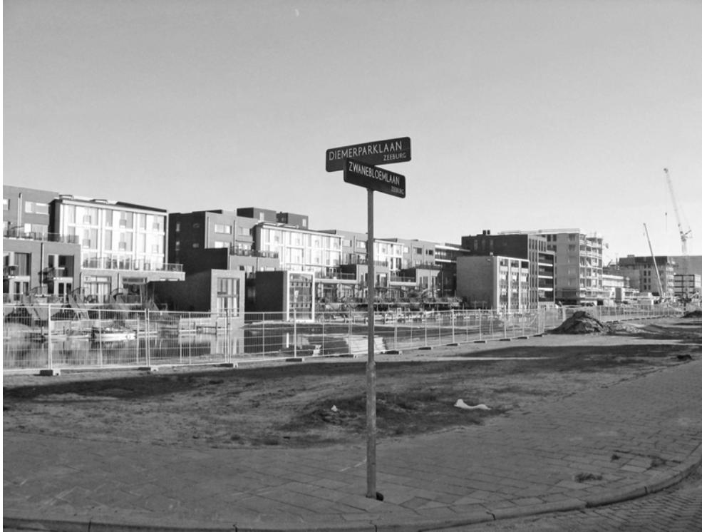
Ijburg in aanbouw
