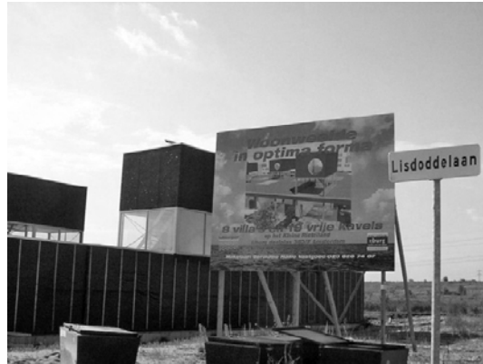
Zelfbouwkavel in aanbouw [FOTO: LÉON DEBEN]
